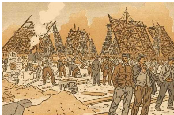
Les Chantiers de la Tour Eiffel/エッフェル塔の建設現場
