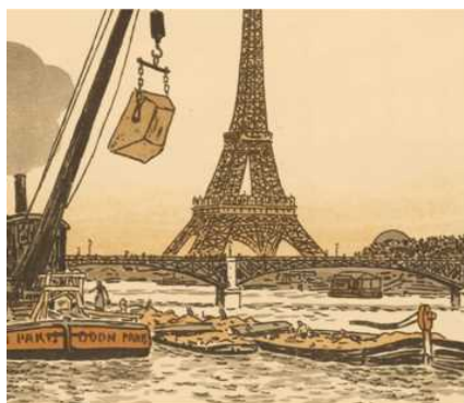
Du Quai de Passy パッシー河岸より
