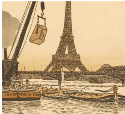
Du Quai de Passy ← パッシー河岸より
