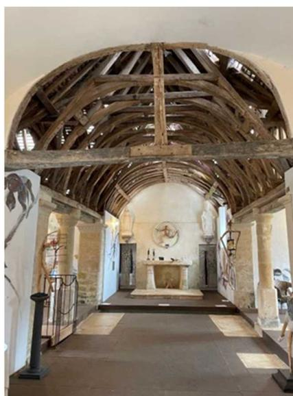
Il fallut onze ans de travaux dont l'essentiel consistait à la réparation du bâtiment. La première étape du chantier fut de démonter la charpente en bois et à réparer
