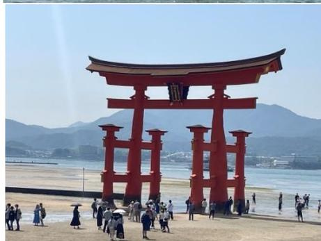
approcher à pied jusqu'à sa base. Une particularité de cette construction réside dans la présence de piliers auxiliaires, situés à l'avant et à l'arrière des piliers principaux (*hashira*), conçus pour résister à la puissance des marées et aux forces de l'eau. Il est probable que le *torii* du Parc Oriental de Maulévrier ait été conçu en prenant pour modèle le grand *torii* du sanctuaire d'Itsukushima, car il
